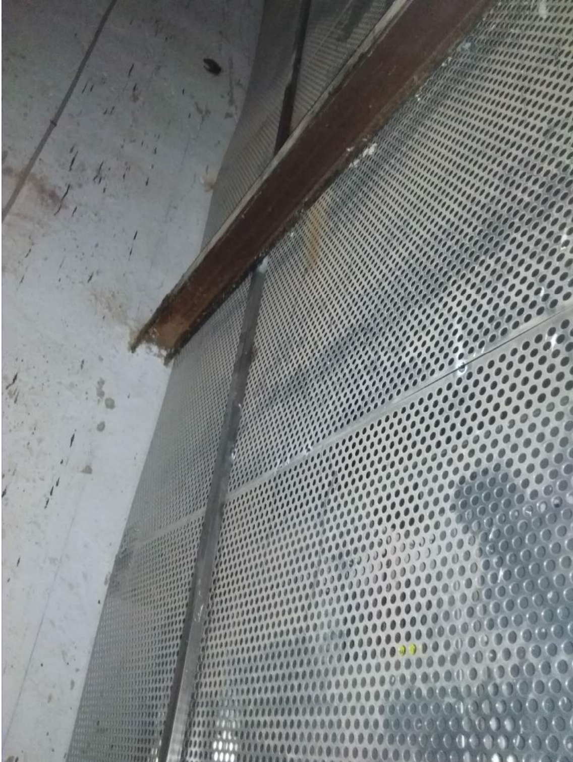
FOTOGRAFIA 3.7: CIERRE METALICO SEPARADOR NO ALINEADO CON EL EJE DE LAS VIGAS MEDIANERAS, CON SOLDADURAS SIN REPASAR Y SIN PINTAR CON IMPRIMACION ANTIOXIDANTE.
