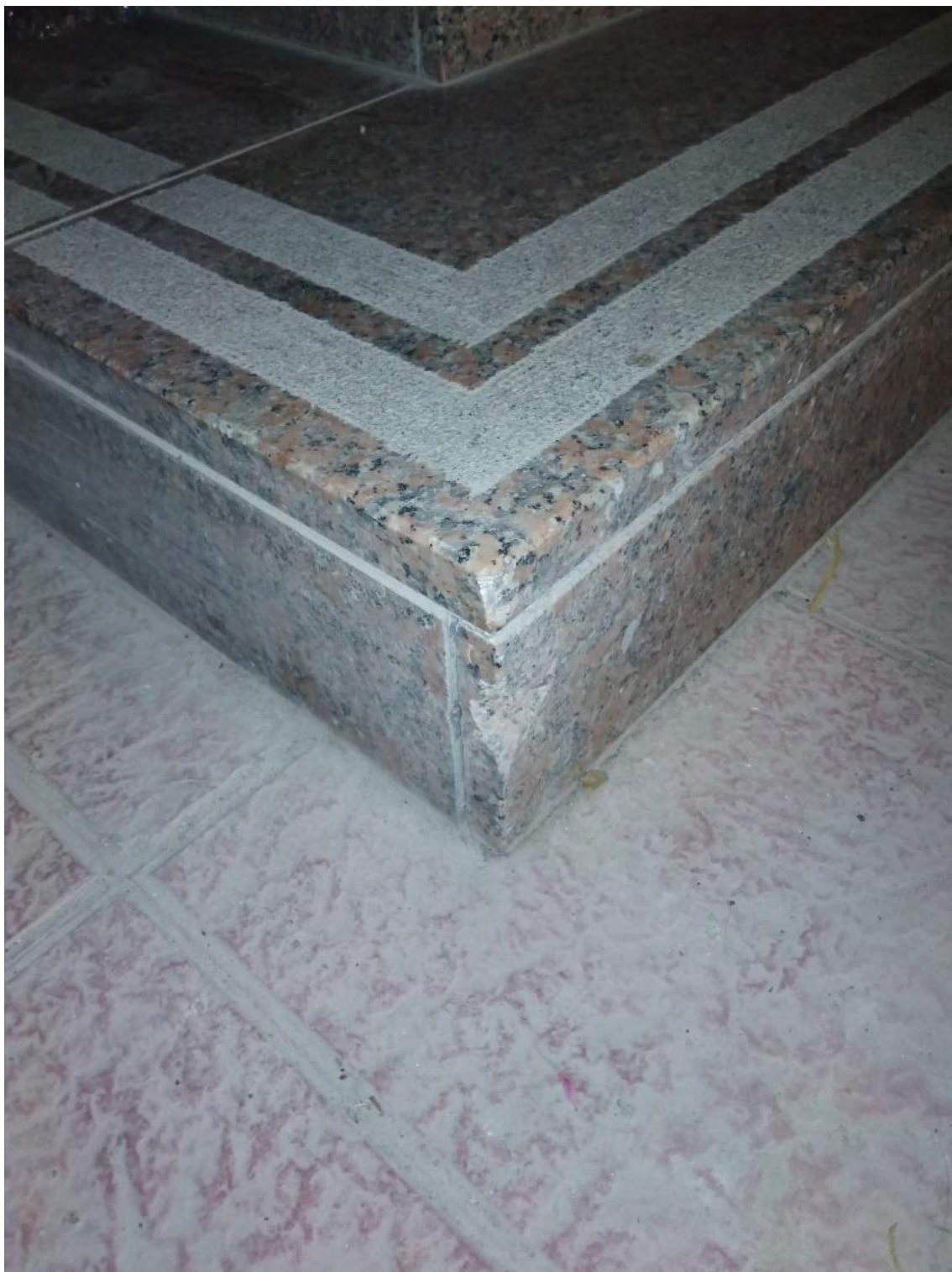
FOTOGRAFIA 3.24: DAÑOS EN EL MARMOL DE ENTRADA AL PORTAL.
