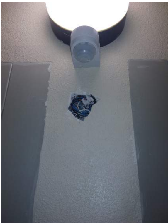
FOTOGRAFIA 3.17: FALTA DE COLOCAR TAPAS DE CAJAS DE DERIVACION DE INSTALACION ELECTRICA EN LAS PLANTAS.
