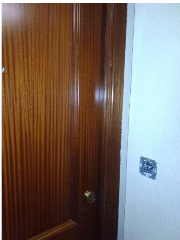
FOTOGRAFIA 3.13: FALTA COLOCAR MARCOS Y TAPAS DE MECANISMOS ELECTRICOS.
