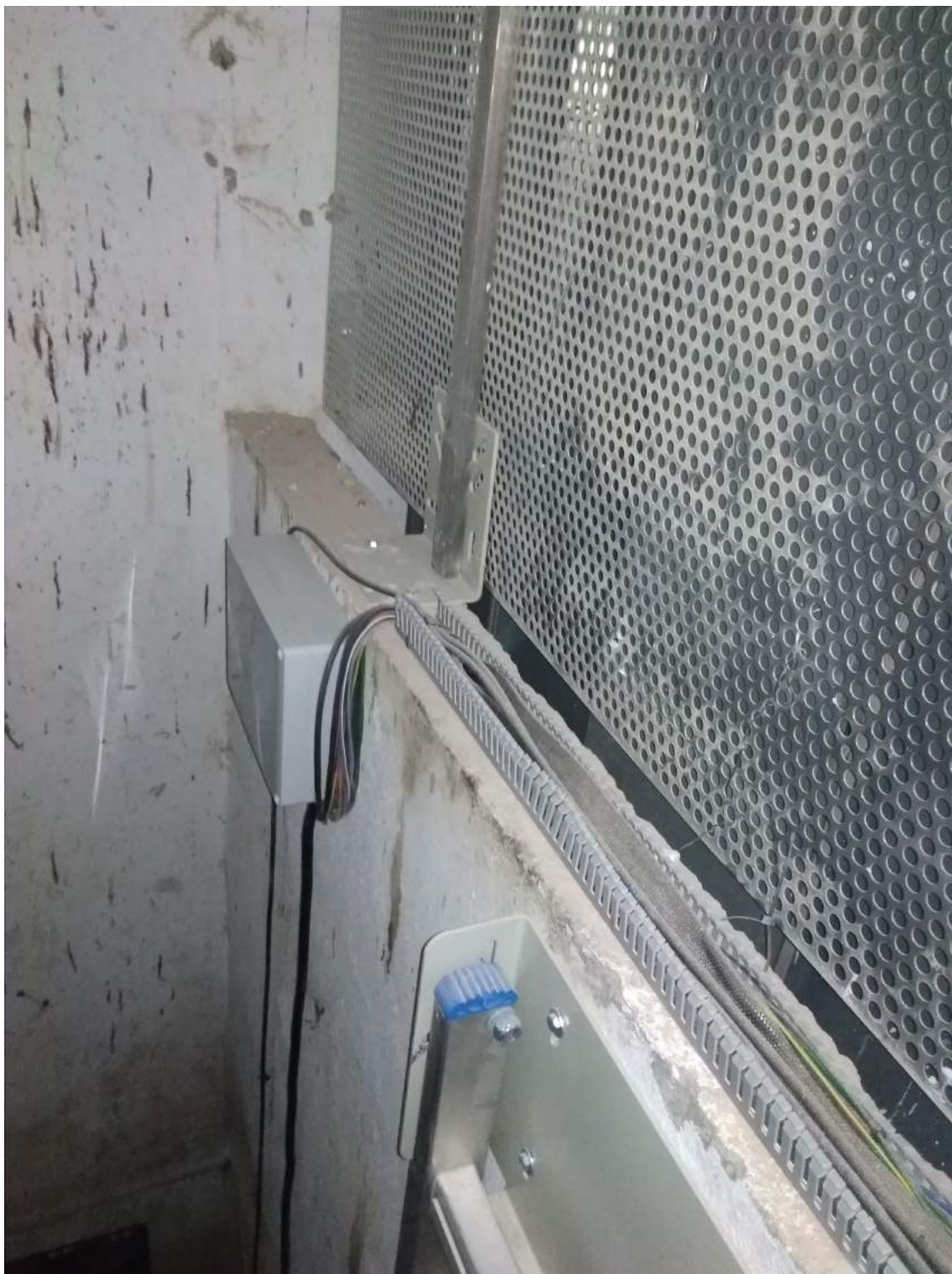
FOTOGRAFIA 3.6: INICIO EN PLANTA BAJA, DEL CIERRE METALICO SEPARADOR DE AMBOS HUECOS. CANALIZACION ELECTRICA ABIERTA.
