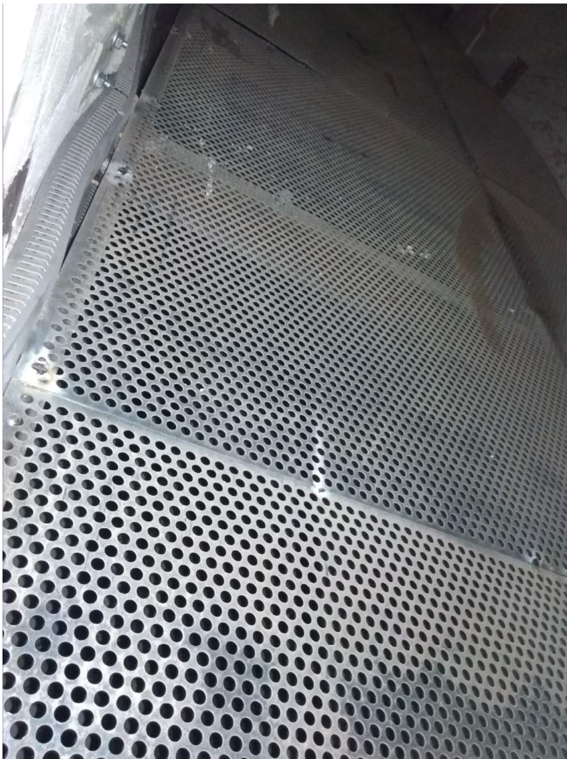
FOTOGRAFIA 3.8: CIERRE METALICO SEPARADOR CON SOLDADURAS SIN REPASAR Y SIN PINTAR. CANALIZACIONES ELECTRICAS "SERPENTEANTES", SIN ALINEACION.
