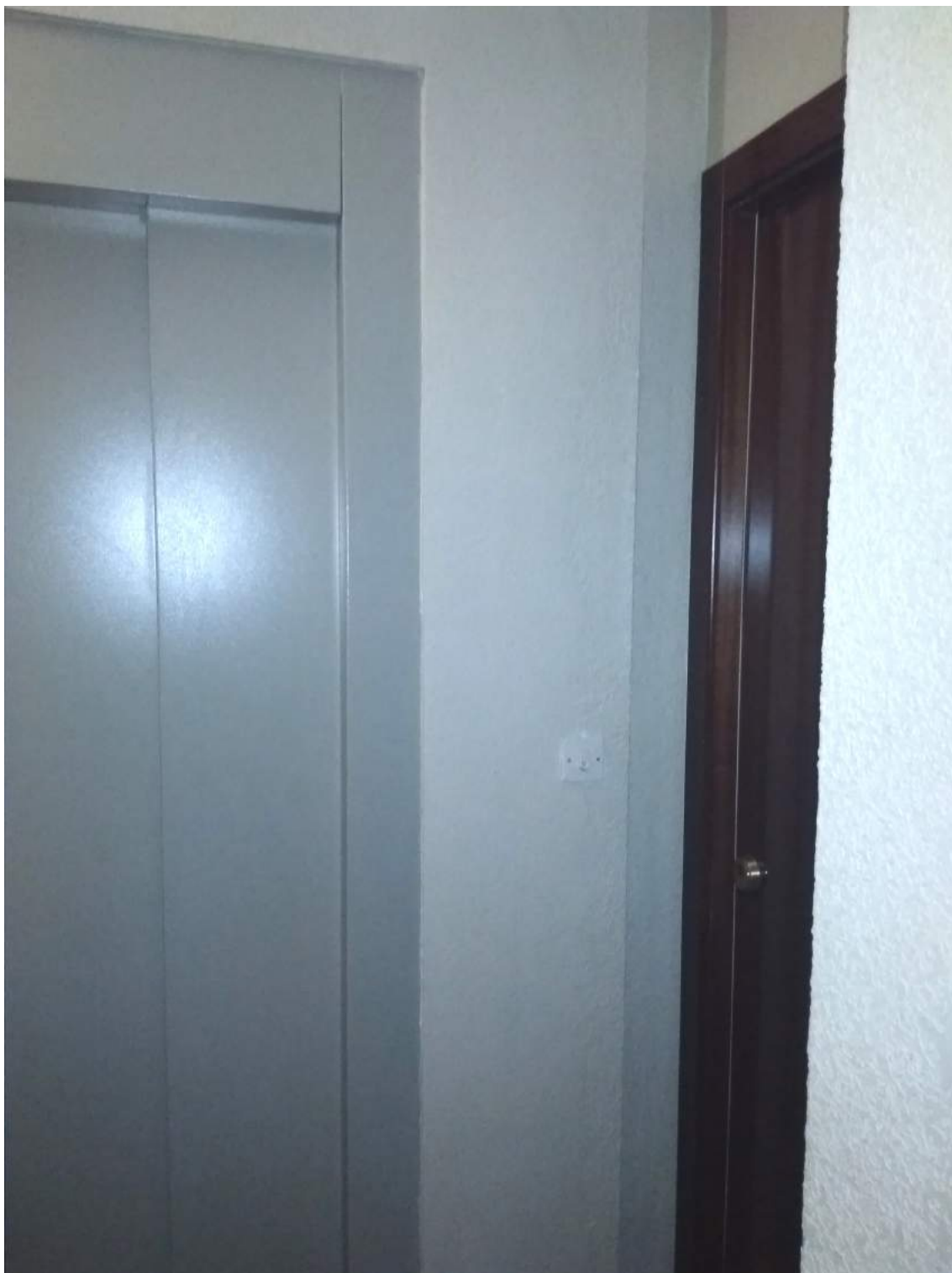
FOTOGRAFIA 3.9: MURO DE PUERTA DE PLANTA SOBRESALIENDO SOBRE PUERTA DE VIVIENDA. (VEASE COMO EL MARCO DE LA PUERTA DE VIVIENDA QUEDA METIDO EN LA CAJA FORMADA ENTRE AQUEL Y EL MURO DE LA PROPIA PUERTA)
